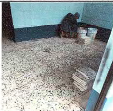
Foto1: COLOCACION DE PISOS DE GRANITO
