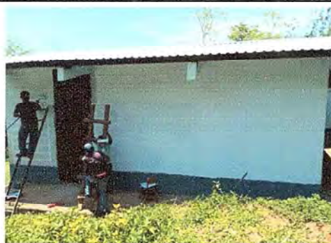
Foto 4: SE OBSERVA QUE ESTAN PINTANDO EL MODULO
