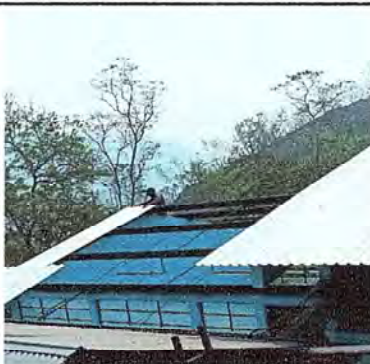
Foto 2: COLOCACION DE TECHO
